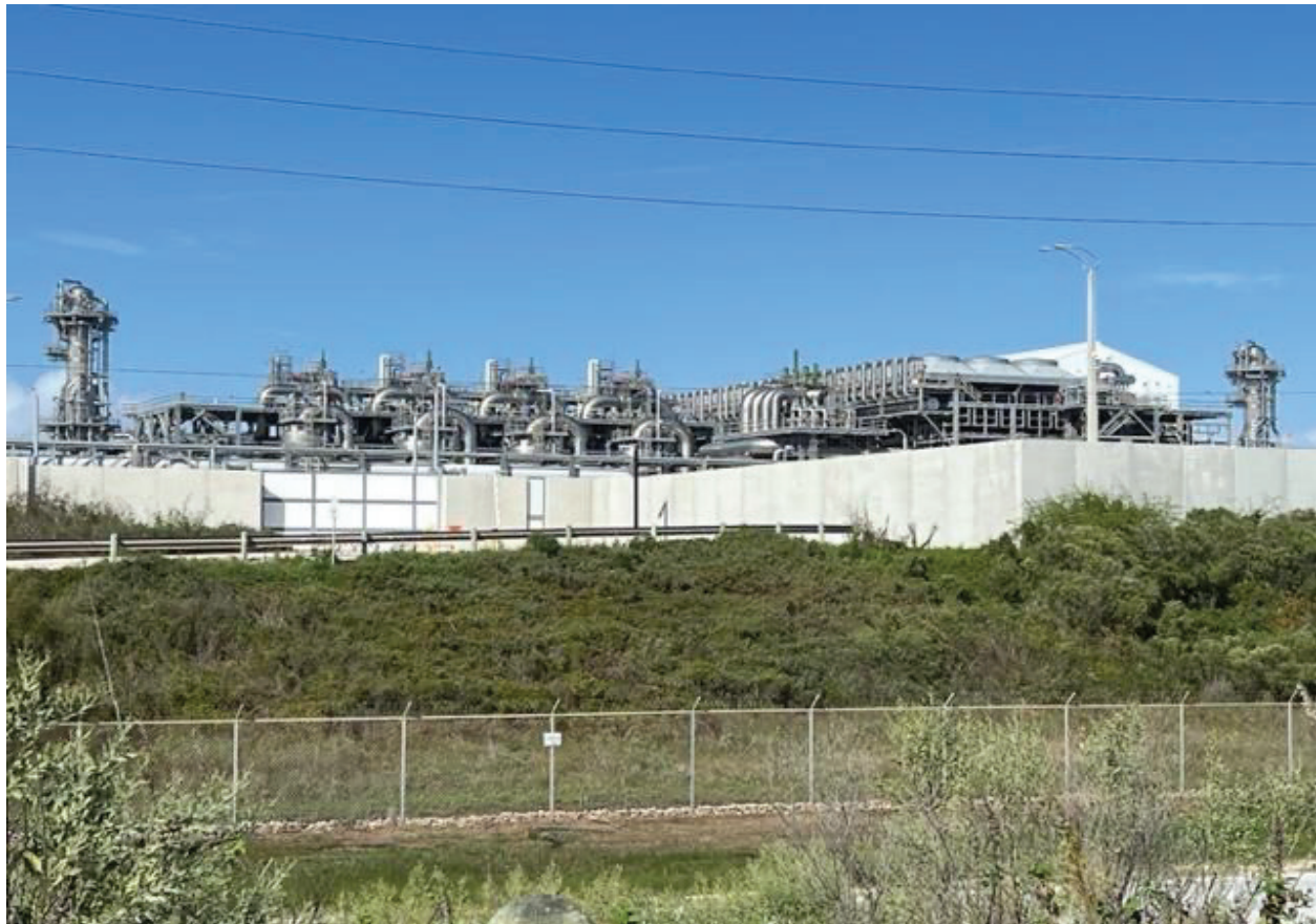
Figure 6.5. Trains at Freeport LNG
